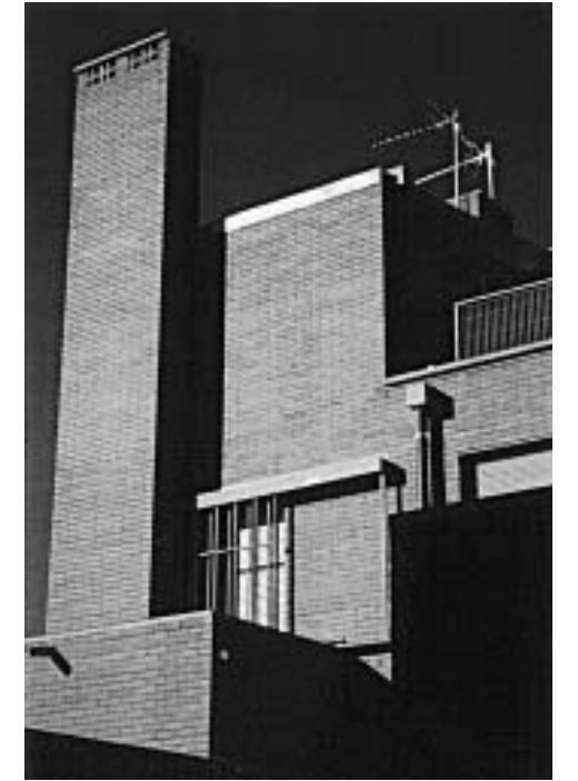
Vista de los distintos remates de cubierta
