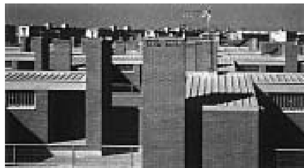
Tratamiento de las cubiertas a dos aguas
