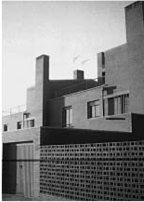
Vista del cerramiento de parcela
