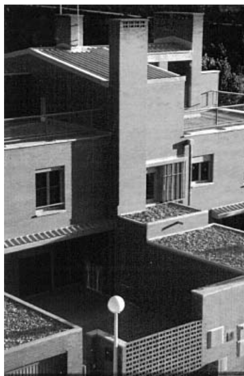
Vista de la volumetría de la vivienda desde SO
