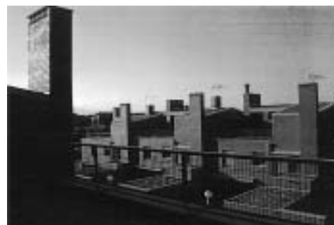
Vista de los distintos tratamientos de cubierta
