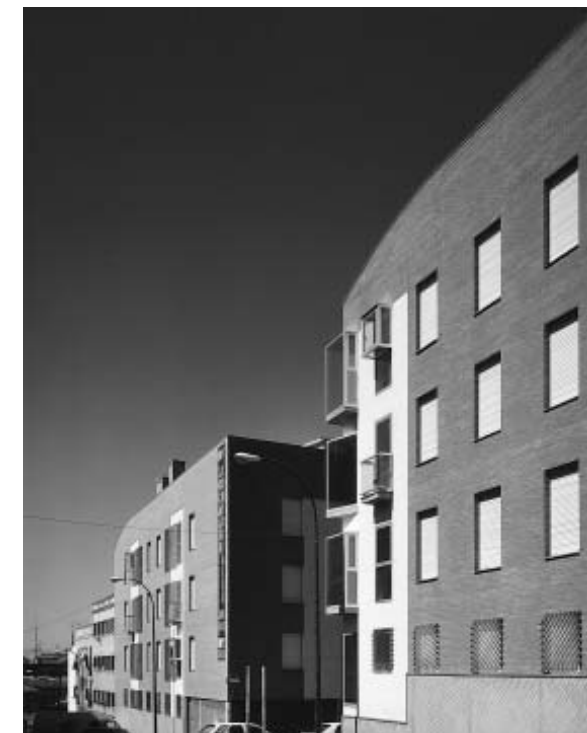
Vista general de los bloques I y II
