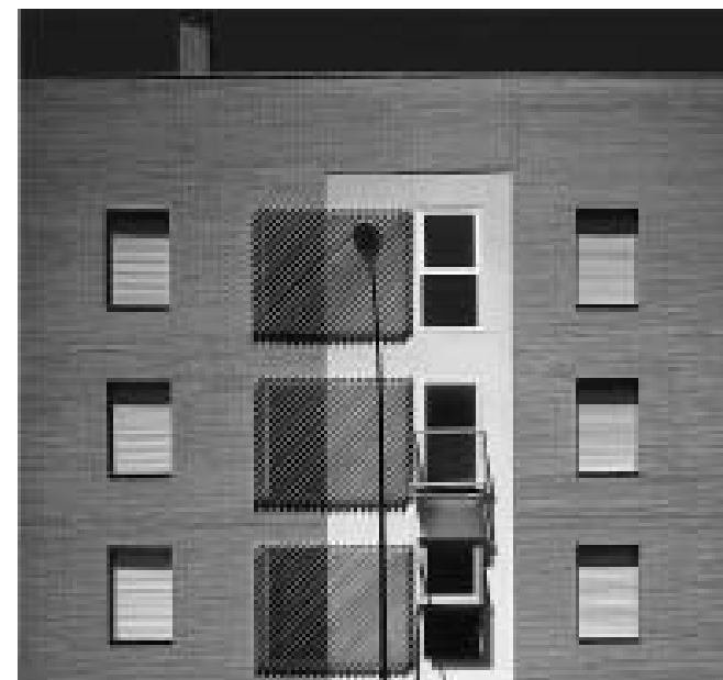
Detalle de los distintos huecos de fachada
