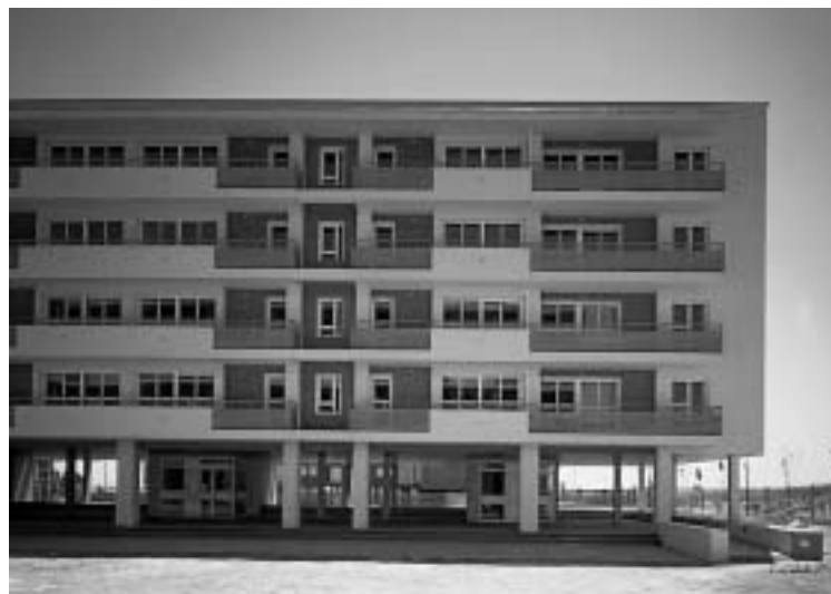
Vista de la fachada interior
