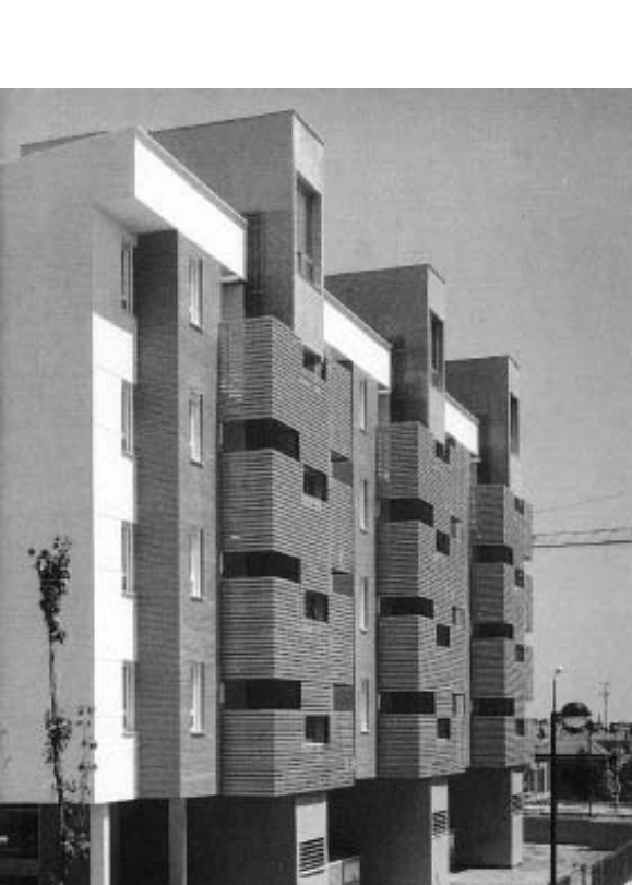
Vista de la fachada desde el SE
