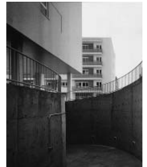
Acceso a garaje
