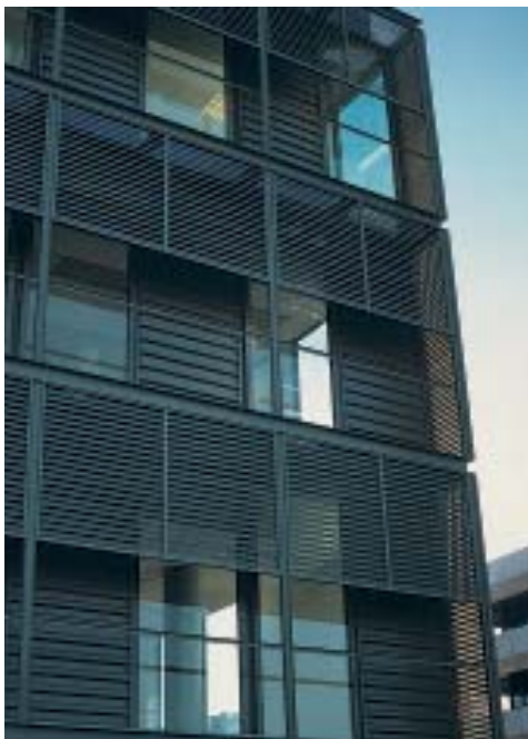
Vista del cerramiento en la fachada O
