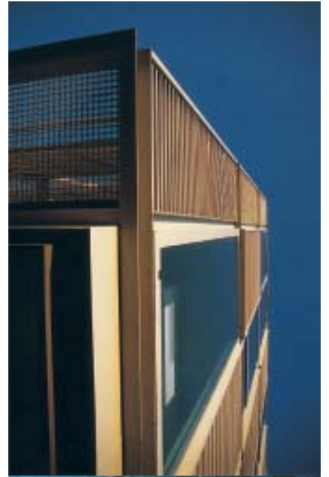
Vista del remate inferior de fachada
