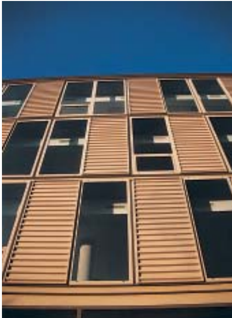
Cerramiento de la fachada S
