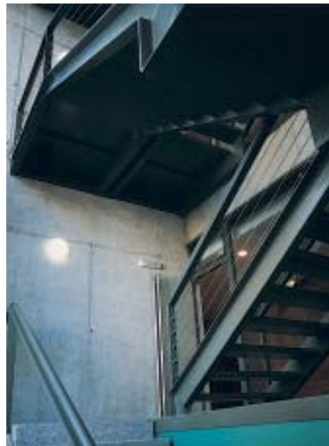
Acabados de la escalera
