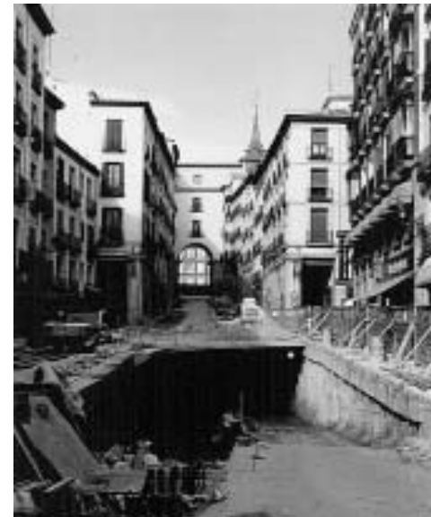
Vista de la C/ Toledo durante las obras del paso subterráneo
