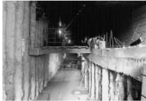
Vista del estado de las obras del paso subterráneo
