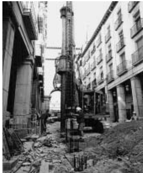
Realización de pilotes en el centro histórico
