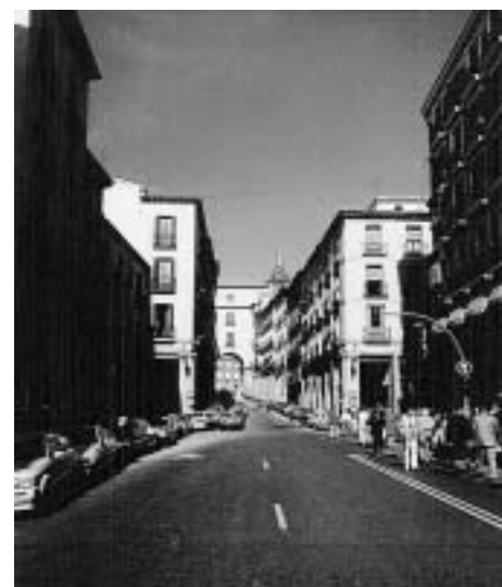
Vista del cruce entre la C/ Toledo y la C/ Lechuga, antes de la recuperación
