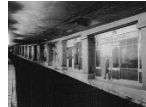
Vista del primer nivel del paso subterráneo
