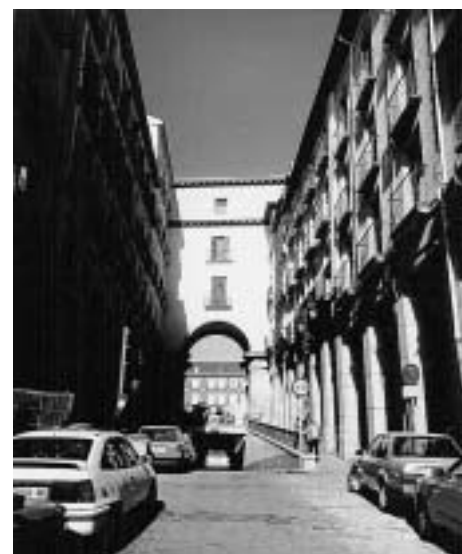
Vista de la rampa de acceso al aparcamiento entre los pórticos de la calle
