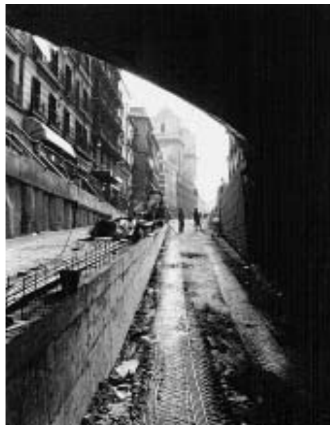
Vista de los accesos subterráneos en obras
