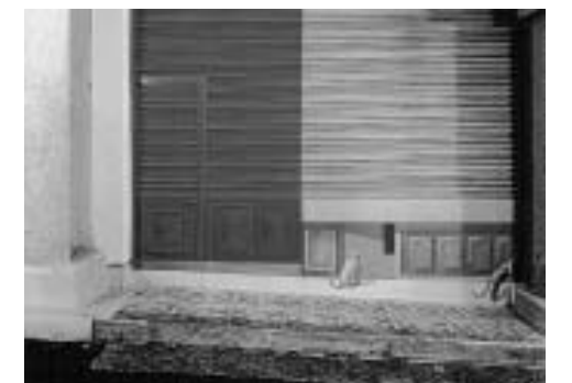
Integración de la rejilla de ventilación del metro en una de las pinturas que escenifican los locales de la C/ Toledo
