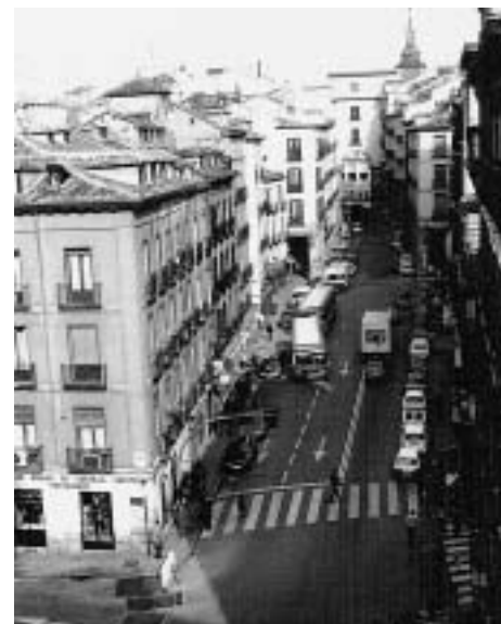
Vista hacia la Plaza Mayor, antes de la intervención
