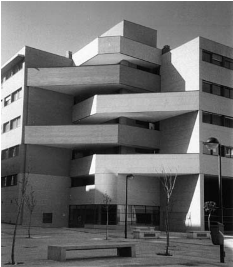
Vista NE de uno de los accesos al edificio
