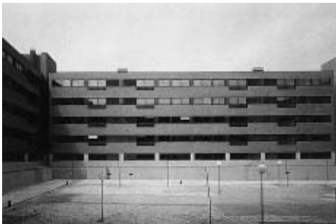
Vista O del interior del patio
