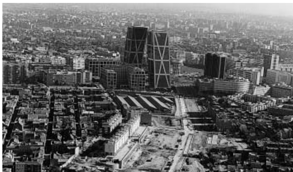
Vista general O del emplazamiento
