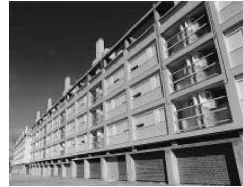
Vista S desde nivel de entreplanta
