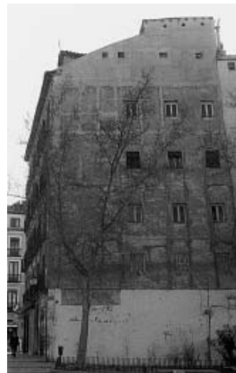
Vista de la fachada O; estado inicial
