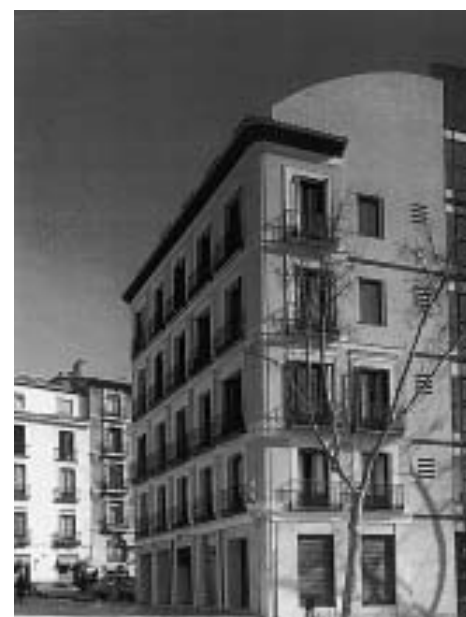
Vista de la fachada O; estado actual
