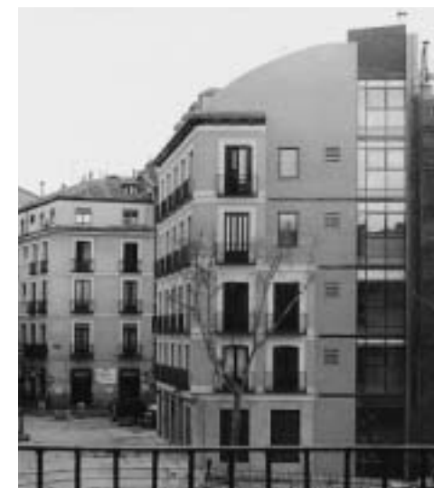
Tratamiento de la fachada O
