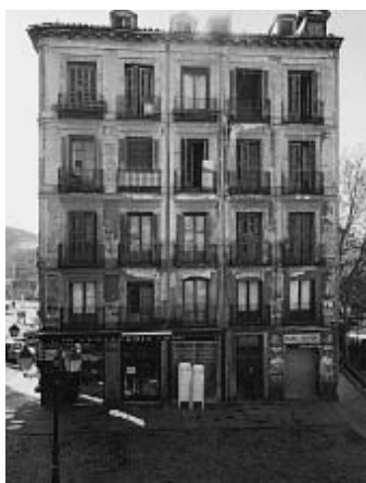
Aspecto inicial de la fachada principal
