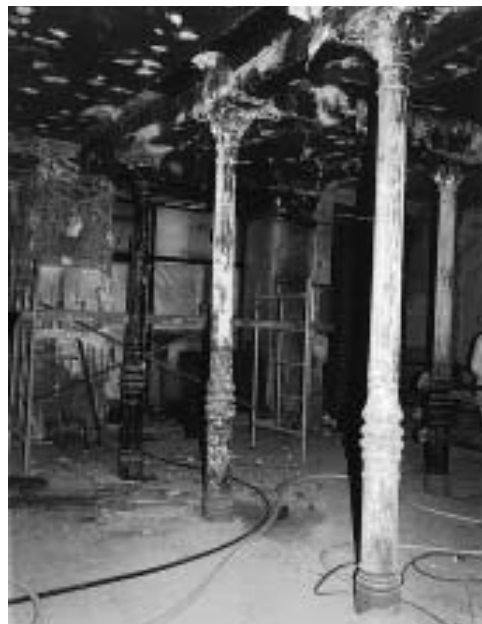
Vista de los pilares de fundación durante las obras, refuerzos con perfiles metálicos
