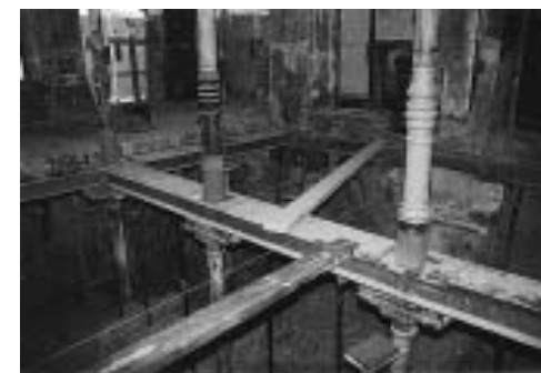
Vista del proceso de la obra
