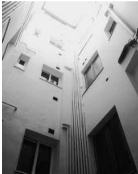
Vista del patio interior después de la rehabilitación
