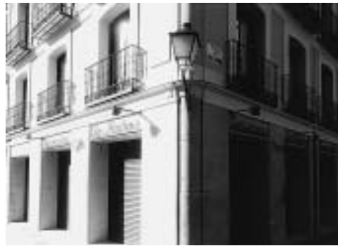
Fachada de local comercial; estado actual
