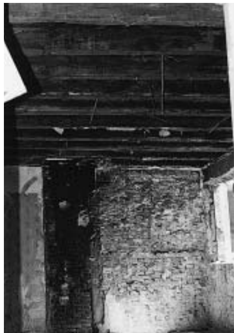
Estado de la estructura y cerramiento del edificio
