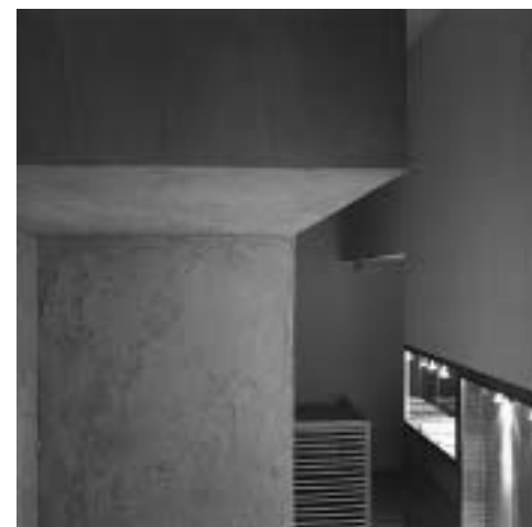
Vista de las diferentes alturas de forjado
