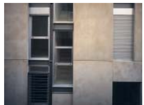
Detalle de los huecos de fachada
