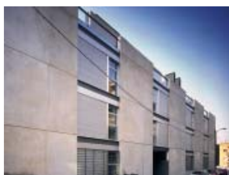
Vista de la fachada NO
