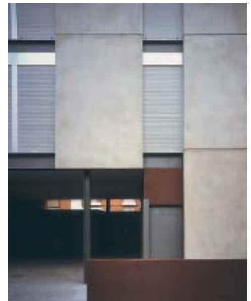
Hueco con panel de hormigón
