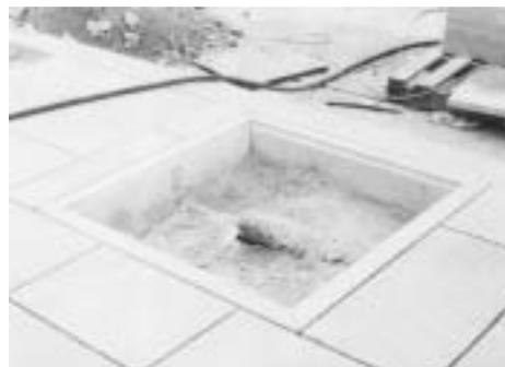
Detalle de alcorque y solado de granito.
