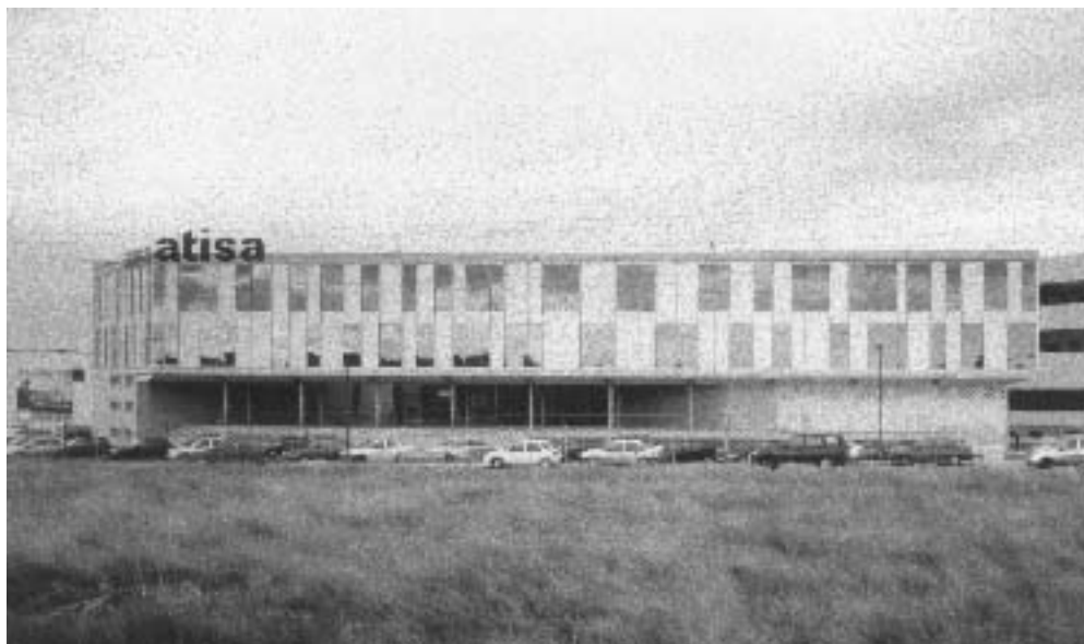
Vista general SE
