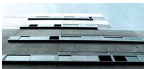
Vista de la fachada a la calle Aruej.
