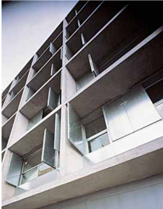
(PF.10) Vista de las cajas voladas en fachada.
