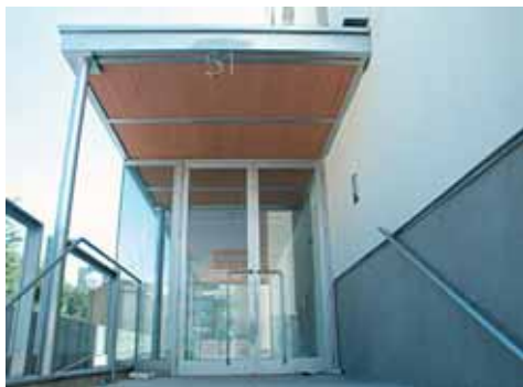
Vista del portal de acceso.
