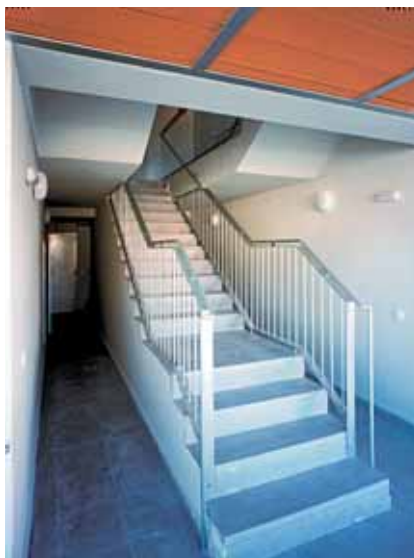
Vista del arranque de escalera en el portal.
