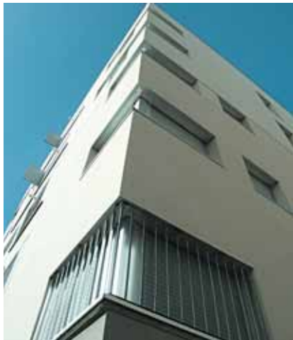
Detalle huecos en encuentro de fachadas S y E.
