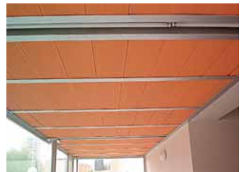
Detalle del acabado de techo en portales.
