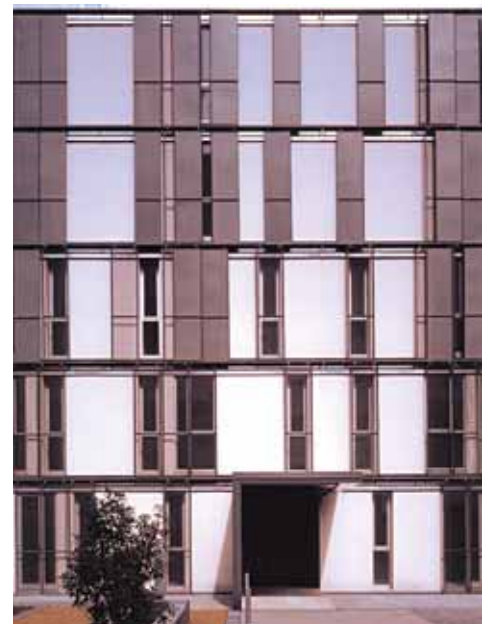
Detalle de fachada Edificio B.
