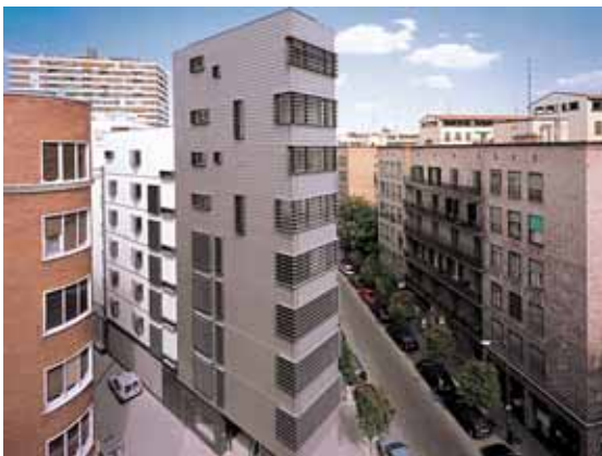
Vista O del Edificio A.
