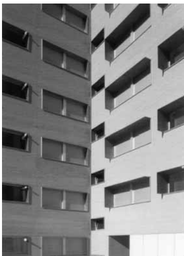
Encuentro entre fachadas E y S del patio interior.
