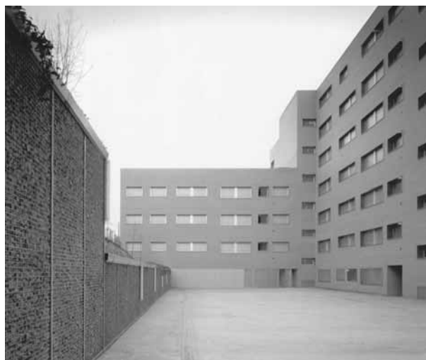
Vista general del patio interior, fachadas E y N.
