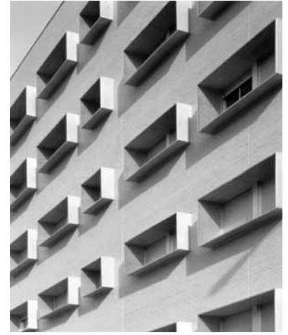
Detalle de la fachada O.
