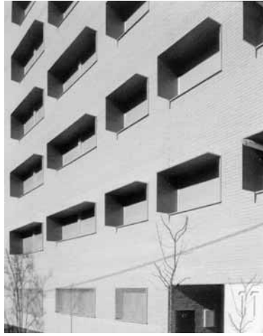
Detalle de la fachada S.
