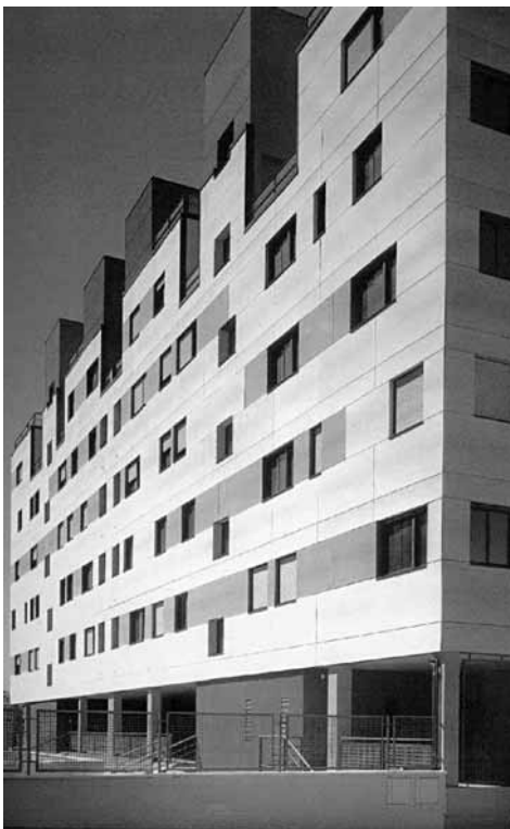
Vista de la fachada E.
