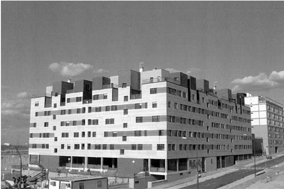
Vista general NE.
