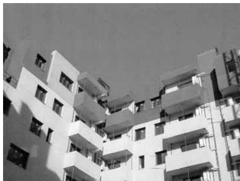
Vista del patio interior.
