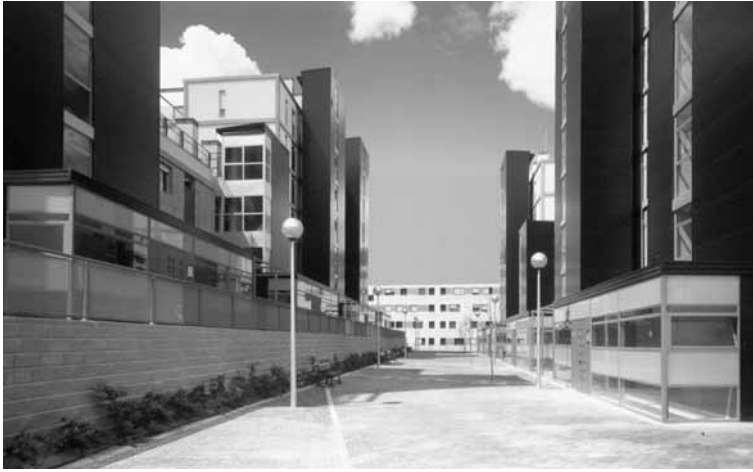
Vista del patio interior.
