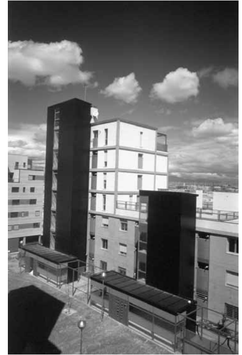
Vista general SE de la fachada interior.
