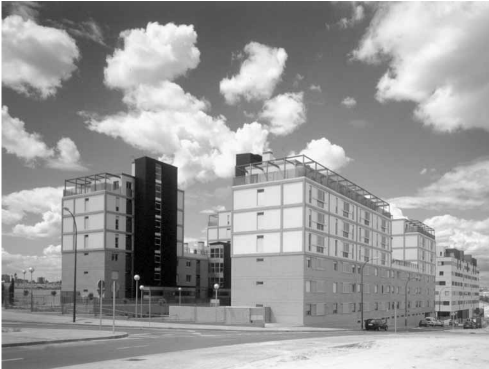
Vista general E.
