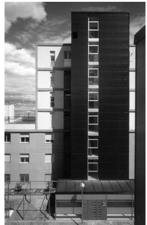
Vista S de la fachada interior.
