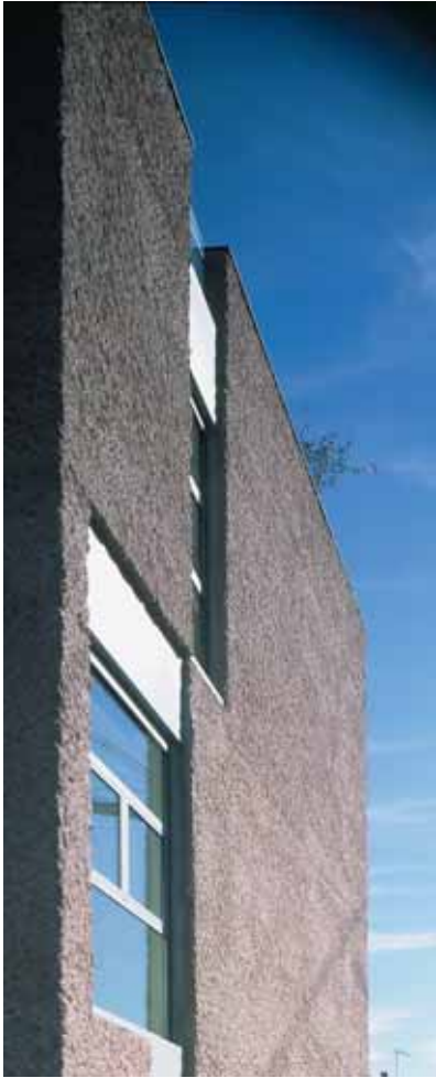
Detalle de la fachada O.
