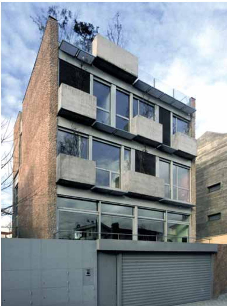
Vista general S.
