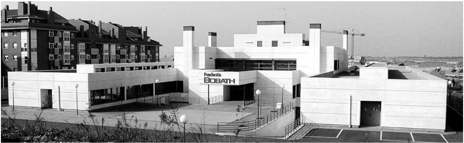
Vista general E.
