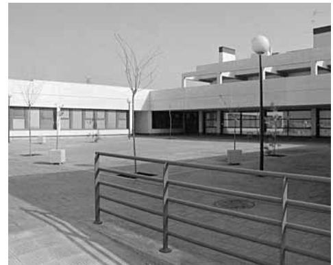
Vista SO del patio de recreo.
