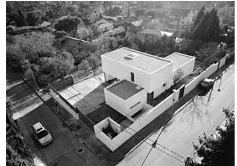
Vista del emplazamiento.
