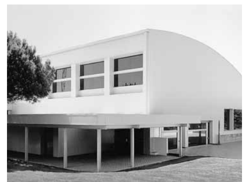
Vista del acceso.
