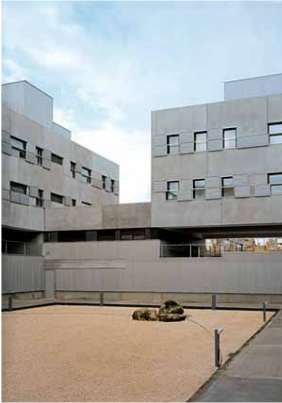
Detalle de fachada interior.
