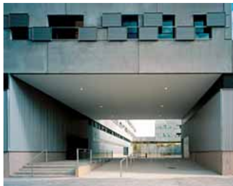
Vista de uno de los accesos.
