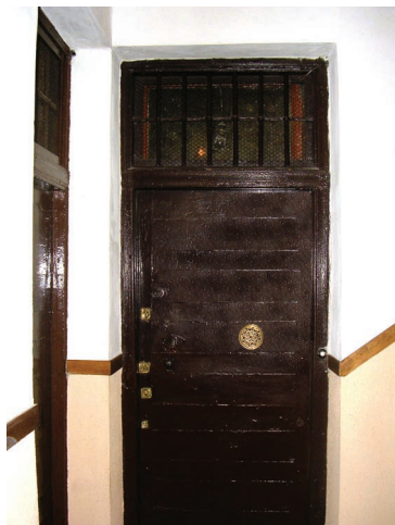
Puerta situada en la escalera en la actualidad
