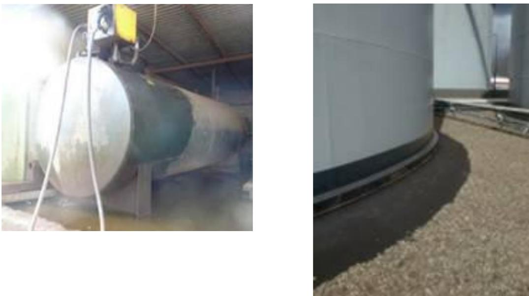
Tanque con pintura anti-corrosiva. Agua presente en cubeto. El potencial de corrosión depende del estado del recubrimiento bajo el agua.
