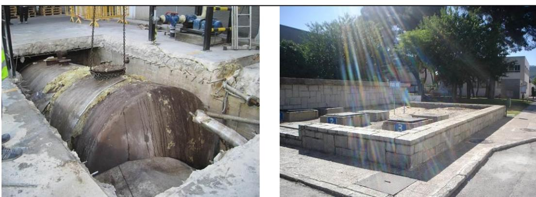
Extracción de tanque subterráneo en mal estado
