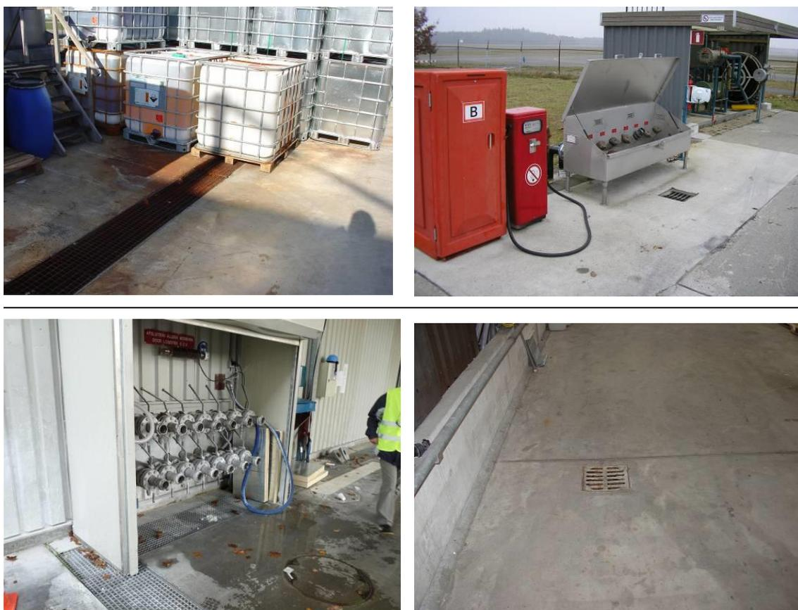
Drenajes adaptados y situados bajo o cerca de focos de contaminación para recoger potenciales fugas.
