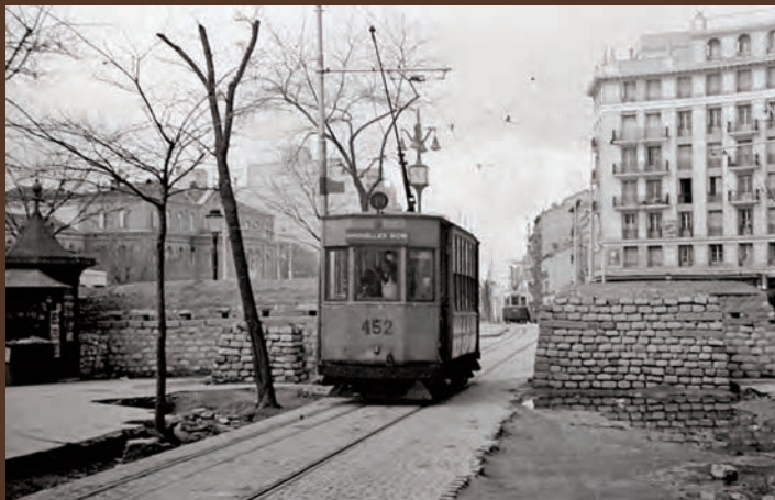
Tranvía circulando a través de una barricada que da acceso a la glorieta de San Bernardo
