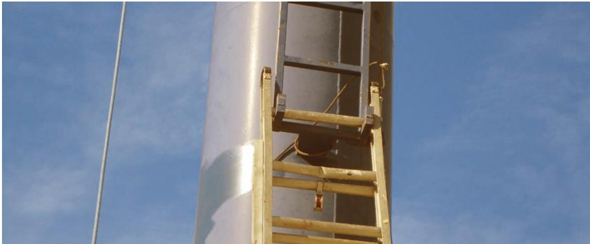
Detalle de escalera manual fijada en anclajes inferiores de escala y línea de vida vertical
