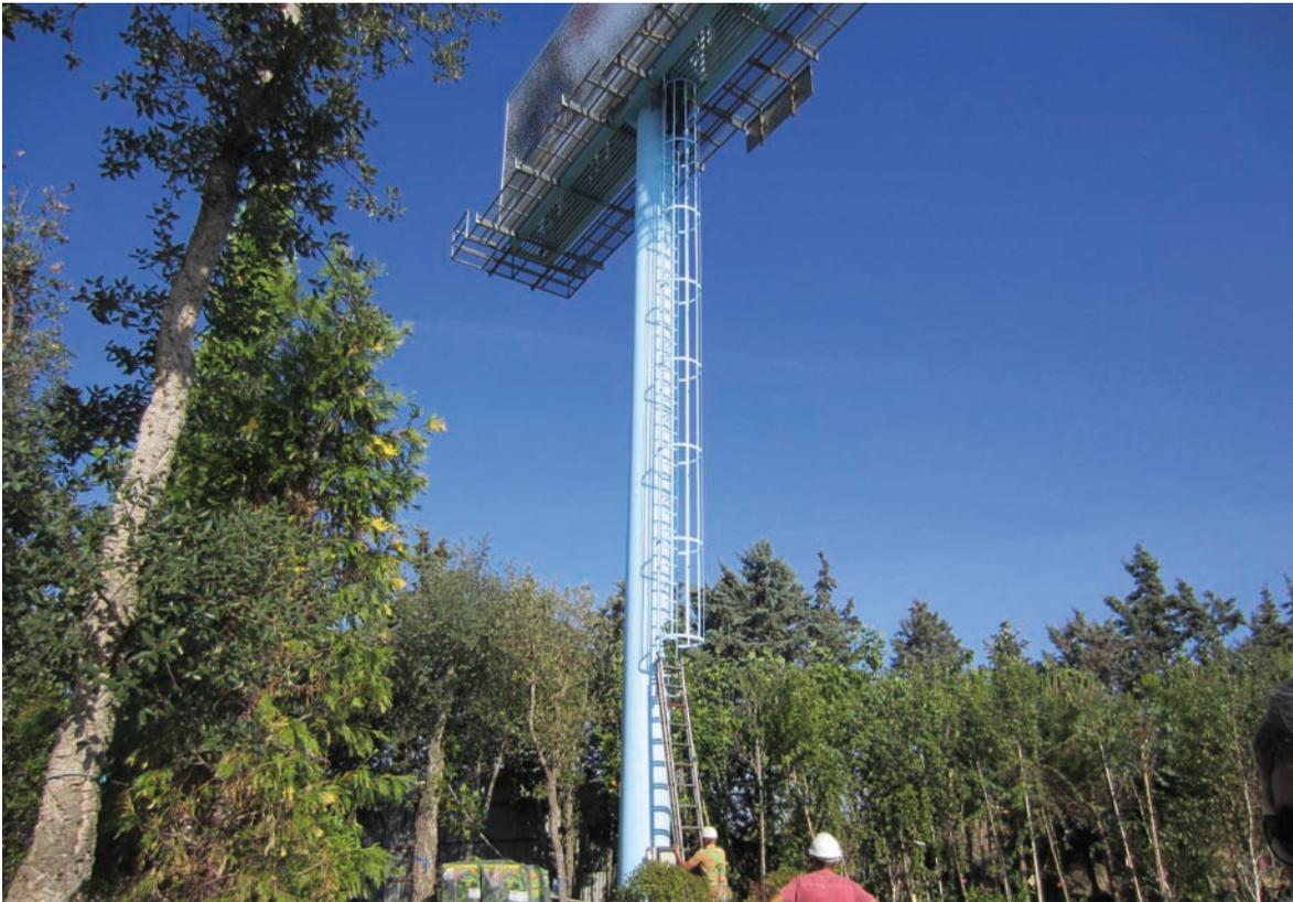
Acceso a monoposte mediante escalera manual, escala con protección circundante y línea de vida
