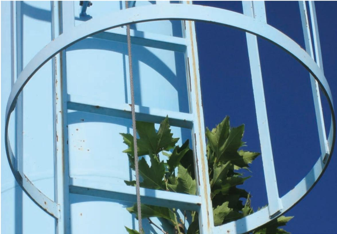
Detalle línea vertical en escala de monoposte
