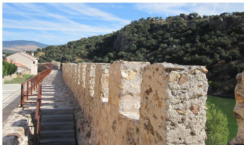
Fig. 24 Adarve bajo del recinto amurallado de Buitrago
