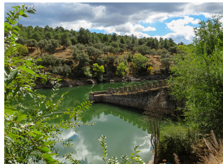
Fig. 26 Coracha del recinto fortificado de Buitrago
