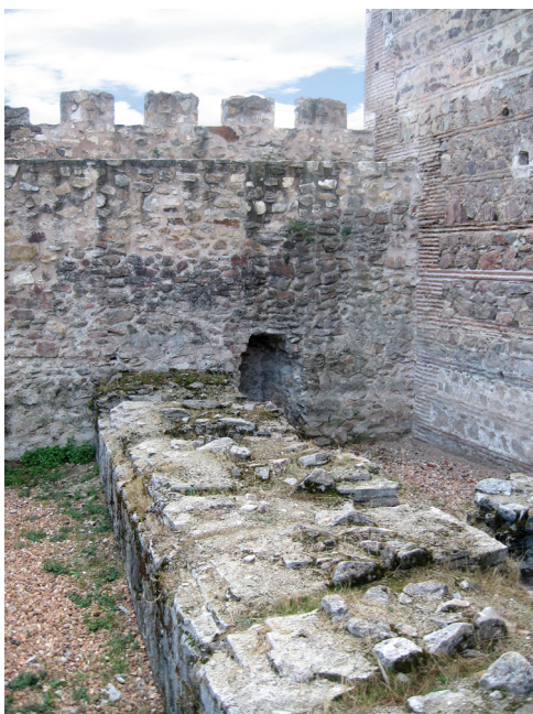
Fig. 20 Restos del antemuro que protegía el castillo
